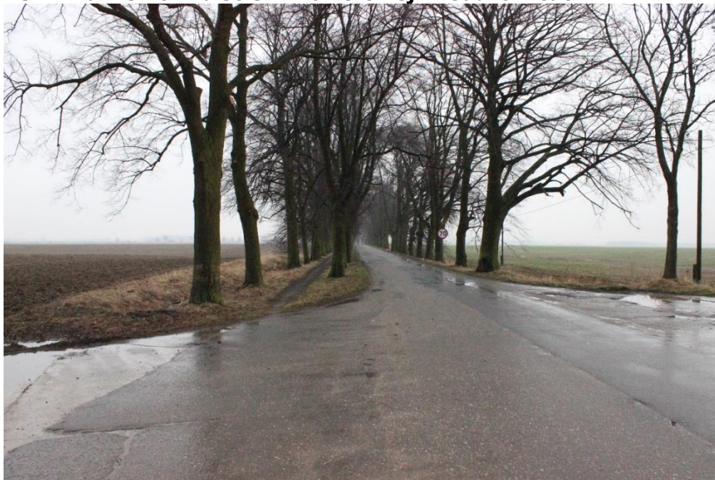
Rysunek 1 Nawierzchnia ścieżki rowerowej w Gadzowicach
