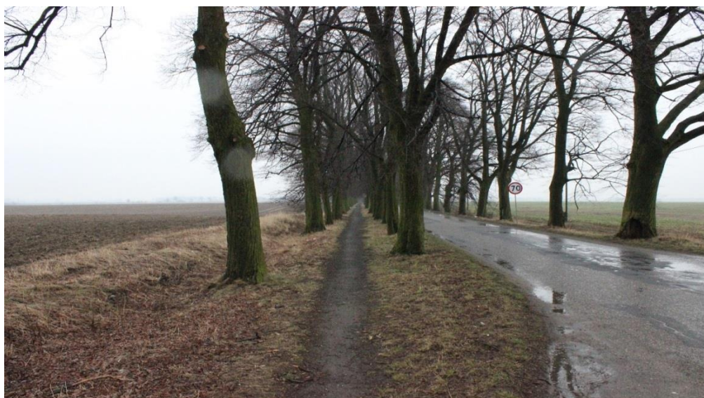
Rysunek 2 Ścieżka oddzielona od drogi asfaltowej, brak oznakowania w Gadzowicach
