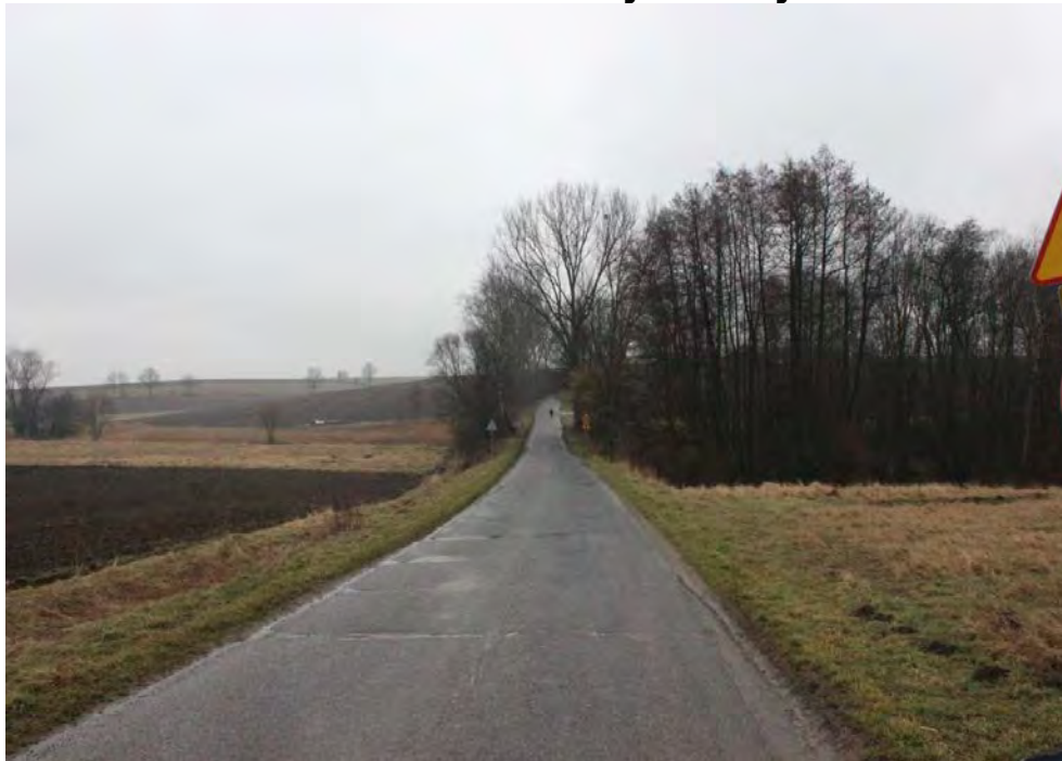
Rysunek 17 Nawierzchnia ścieżki rowerowej w Nowej Wsi
