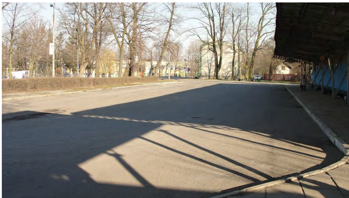
Rysunek 21 Nawierzchnia dworca autobusowego w Głubczycach
