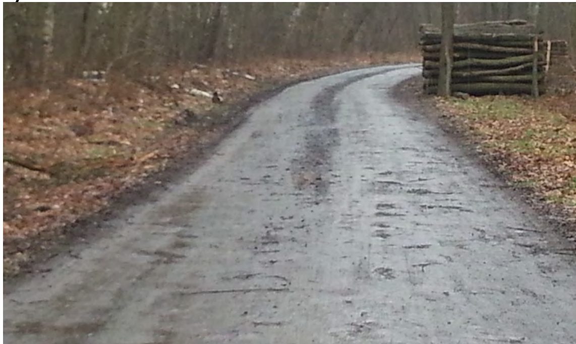
Rysunek 16 Nawierzchnia na odcinku Malerzowice Wielkie-Sowin
