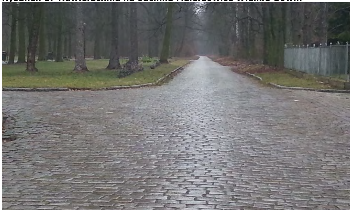
Rysunek 17 Nawierzchnia na odcinku Malerzowice Wielkie-Sowin
