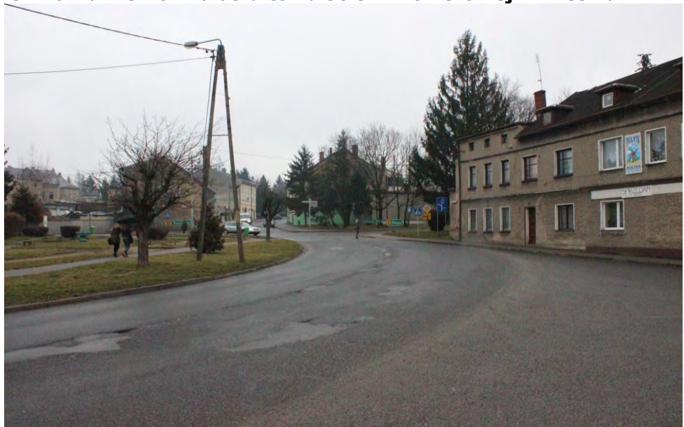
Rysunek 20 Nawierzchnia asfaltowa ścieżki rowerowej w Kietrzu
